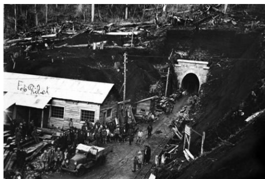
Trabajos en la boca del túnel durante el rescate
